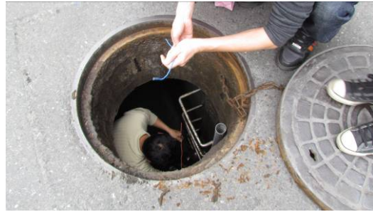
圖 6 羅東市區及打那岸圳取水閘門進行水位計設置
