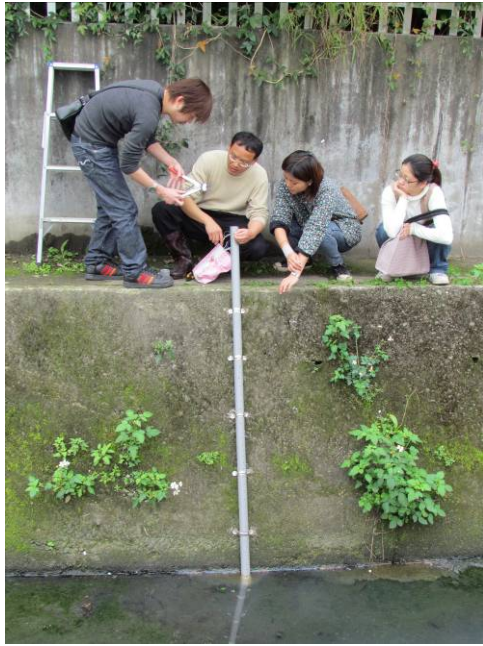
圖 6 羅東市區及打那岸圳取水閘門進行水位計設置
